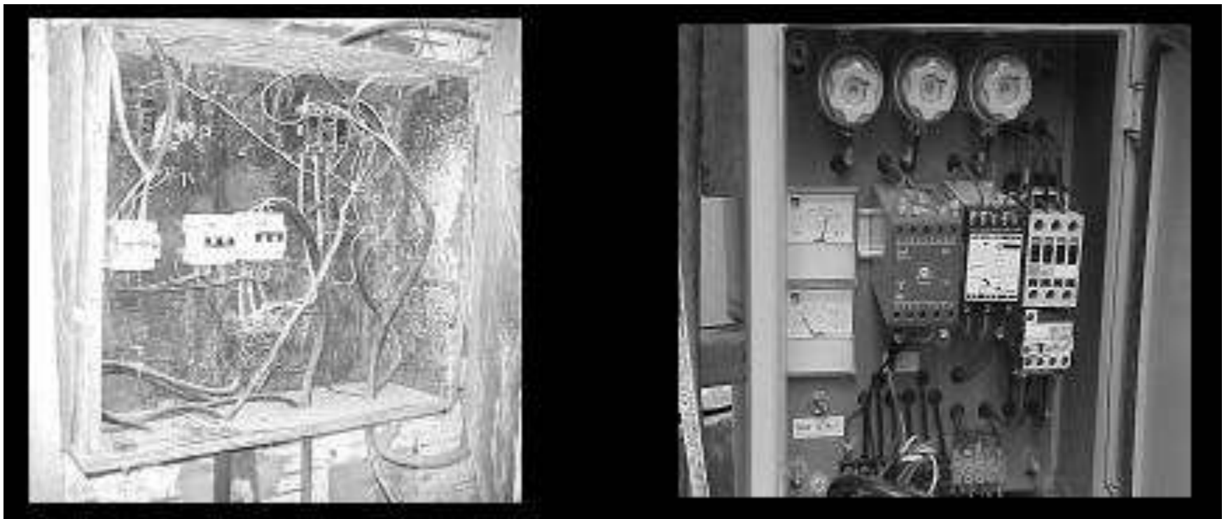
Figura 2 - Imagens de quadros de distribuição: A - desacordo as normas; B – conforme as normas
